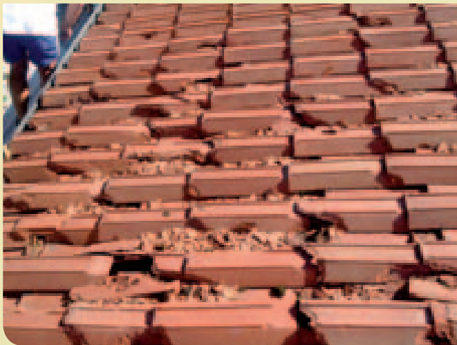
Il tetto del Centro Culturale prima dell'intervento e del posizionamento dei pannelli fotovoltaici
