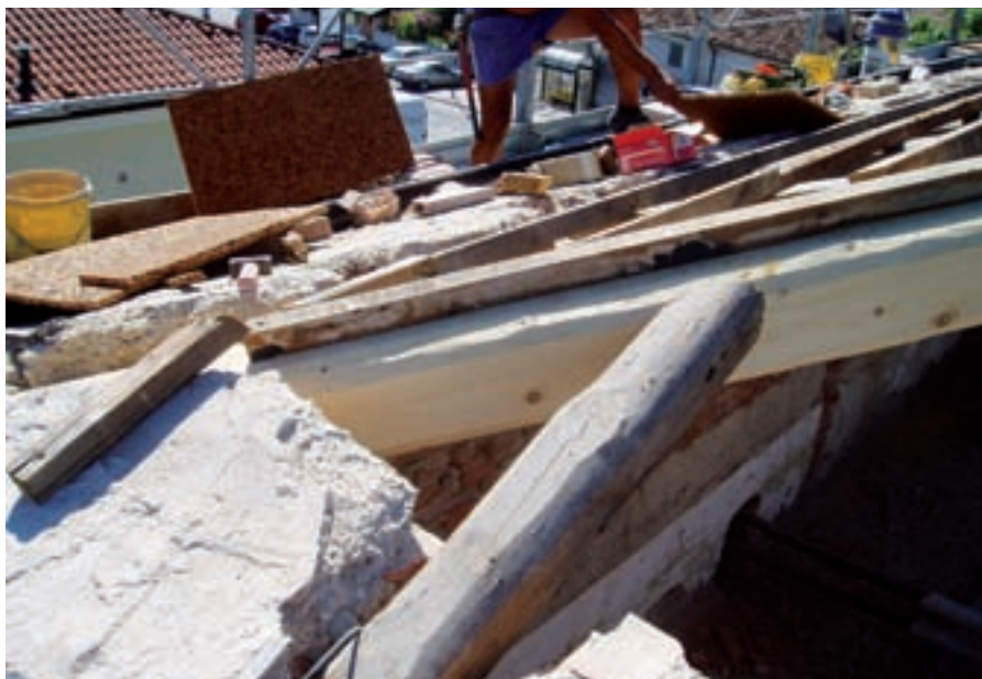
Lavori in corso sul tetto dell'Asilo di San Marco
